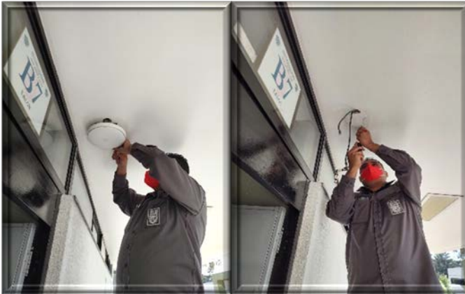
Instalación de Acces Point
